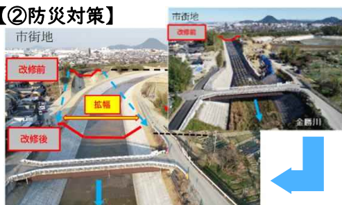
洪水対策のための流下能力向上 (河川改修事業)
