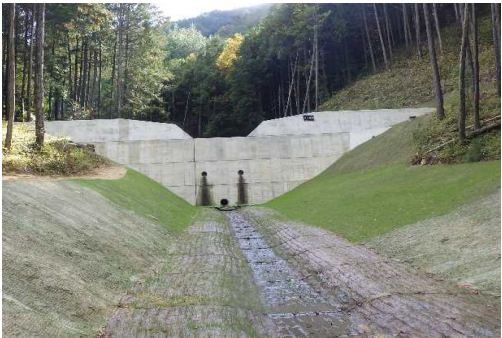
谷止工を設置
