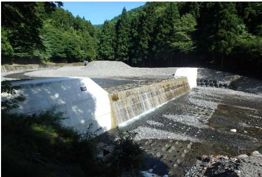
補修による機能回復
