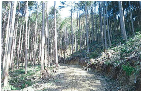
作業道施工後(間伐も実施)
