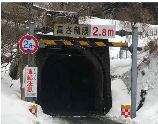
写真 1 柳ヶ瀬トンネル
