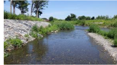
石田川多自然川づくり（環境保全カゴ型護岸） （高島市今津町福岡他）
