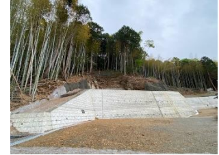
山腹工 (重力式擁壁)
