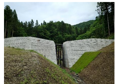
溝谷川砂防堰堤 (長浜市)
