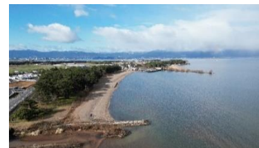
菖蒲浜砂浜保全（突堤工、養浜工） （野洲市菖蒲）
