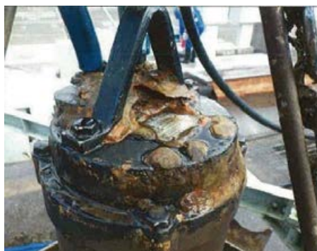
図3. 東北部浄化センターB1-2系水処理施設(腐食)
