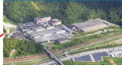
東北部浄化センター（平成3年4月供用）
