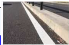
歩車道境界ブロックの一例 滋賀県リサイクル認定製品 パンフレットより
