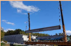
山手幹線道路の整備
