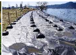
石積み護岸での遮光シート の敷設
