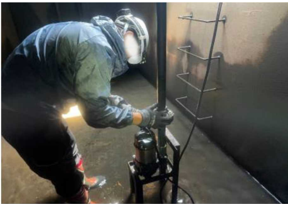
処理水監視槽内にポンプ設置
