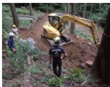
▲作業道作設オペレーター研修
