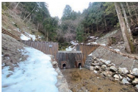
▲治山施設(谷止工)
