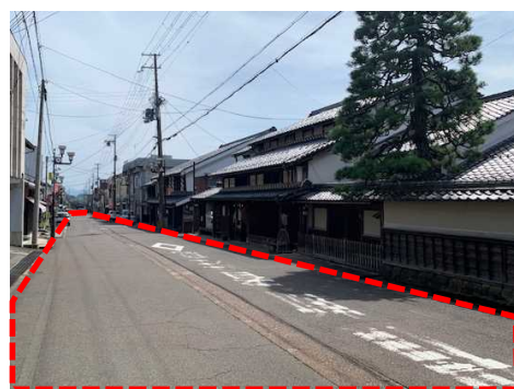
まちなかウォーカブル推進事業 (R5～9) 【長浜市】木之本宿地区 ・道路修景整備
