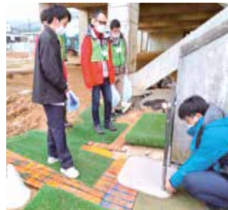
下: 避難所入り口の手すり設置
