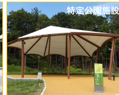
写真③ 屋根付き休憩施設
