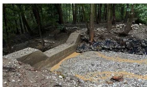
土石流により異常堆積した土砂の浚渫を行った
