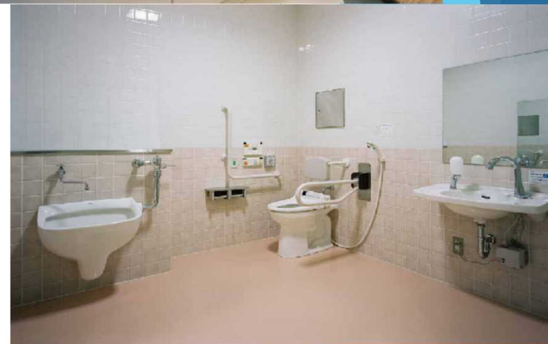
給排水衛生設備
