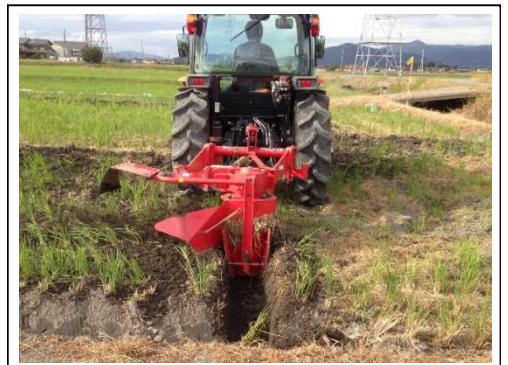
オーガ式溝掘機等で しっかりした排水溝を作る
