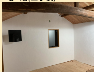
①2階(工事後)
