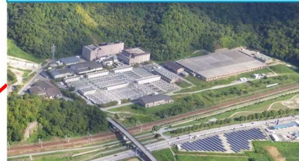
東北部浄化センター（平成3年4月供用）
