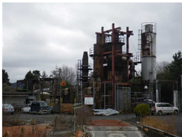
南側焼却炉解体撤去前
