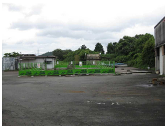
南側焼却炉解体撤去後
