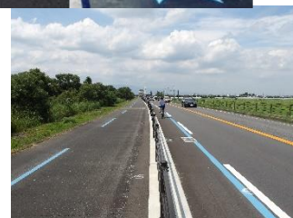
矢羽根による路面表示と案内整備、走行空間整備(拡幅)
