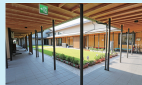
④水口西部コミュニティセンター 「みなくるプラザ」 (甲賀市・木造施設)
