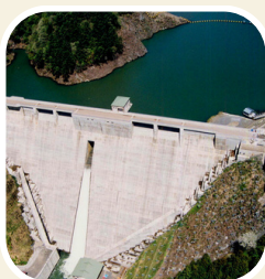
㉔姉川ダム
