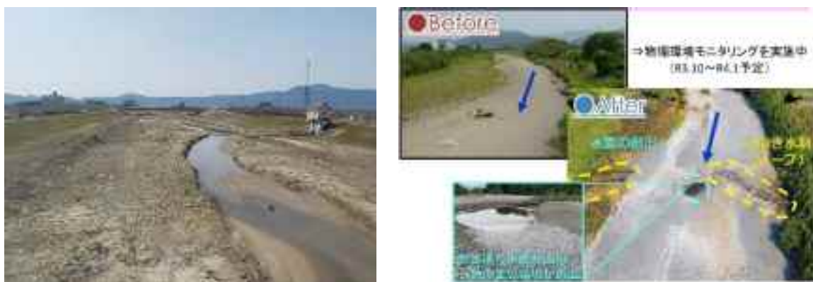
写真 河床の状況 (左:掘削により平坦化した河川、右:バース工の設置例)
