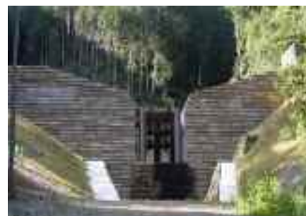
写真 透過型砂防ダム (長久寺川)
