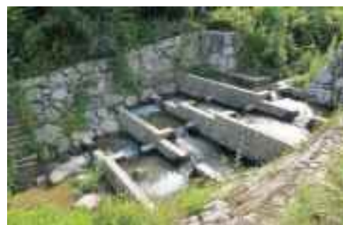
大津市高橋川 つづら折り魚道
