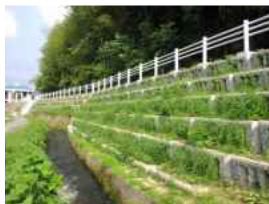
写真 空隙のあるかご型のブロック積 <出典>ランデス株式会社 HP
