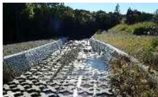
写真 平坦な護床工の例
