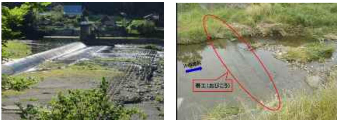
写真 堰・床止め（左：安曇川合同井堰 右：帯工※）
