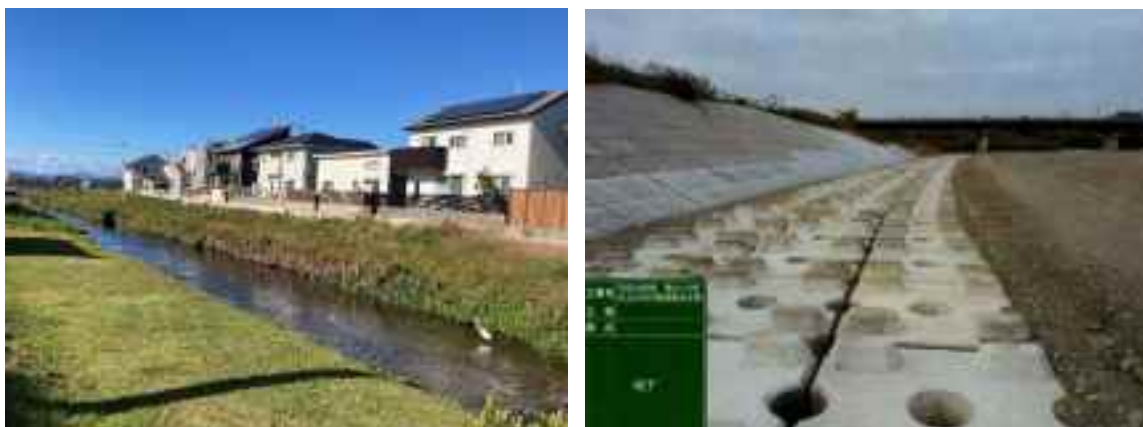
写真 護岸の状況 (左: 木柵と回復した植生、右: 過護岸・過護床の事例)
