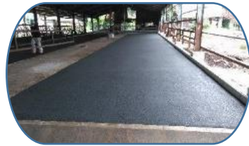
ふん尿分離床工事
