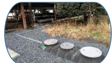
尿用浄化槽工事
