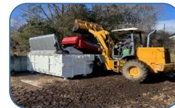
撤去した汚物土を投入
