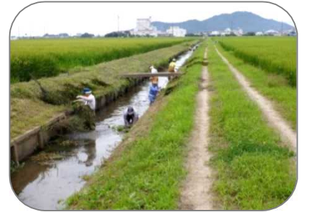
排水路の清掃
