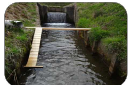
水路からの脱出施設
