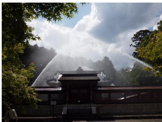
設置した消火設備の放水訓練
