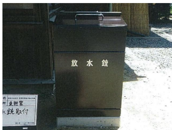
消火設備 放水銃の設置
