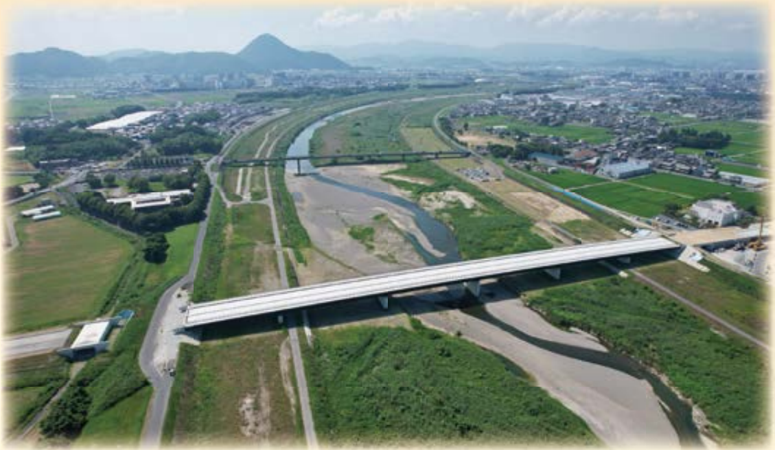
近江八幡守山線（湖南幹線） 近江妙蓮大橋
