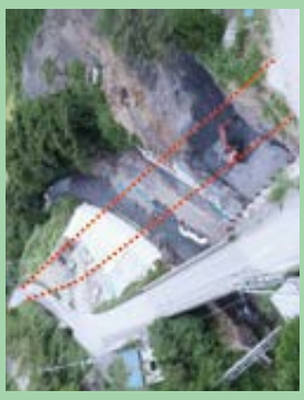
国道303号 道路整備事業
