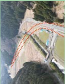
国道303号 道路整備事業
