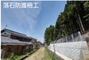
落石防護柵工 久徳地区（多賀町）
