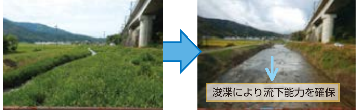
浚渫の状況（大川：長浜市）
