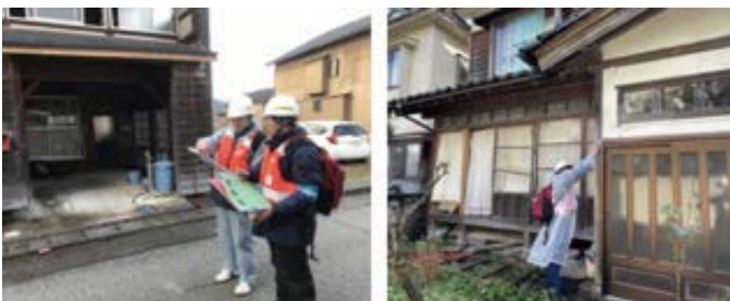
能登半島地震での被災建築物応急危険度判定の様子
