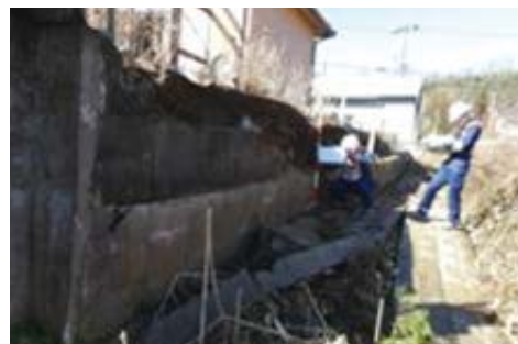
被災宅地危険度判定の様子
