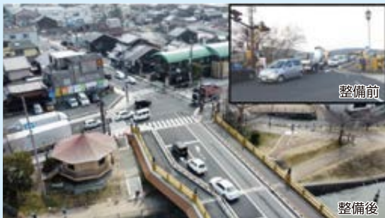
大津能登川長浜線（大津市） 安全な交通の確保と渋滞緩和のため、交差点改良を行いました。
