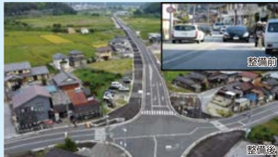
大野木志賀谷長浜線（米原市） 地域の安全確保のため、集落を迂回するバイパス道路を整備しました。
