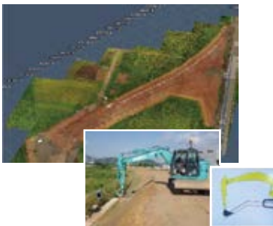
ICT/バックホウによる法面整形 (仕上げ形状データを機械に入れて操作支援)
