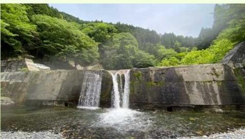
堤体全体にアルカリ骨材反応(ASR)とみられるひび割れ(最大20mm)、放水路天端部の欠損、および基礎部の洗掘が見られた
