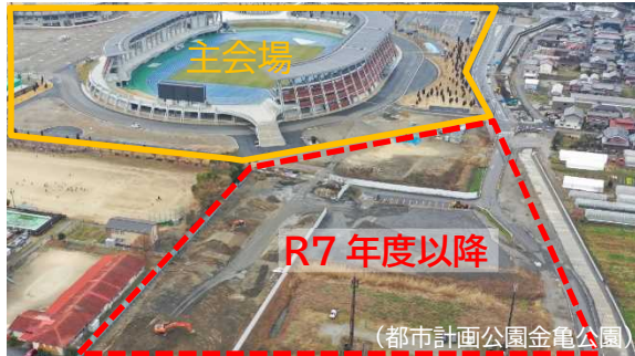
【広域防災拠点となる都市公園】
