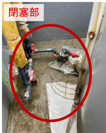
閉塞配管内(PAC結晶化)
