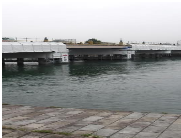
工事中の瀬田唐橋
