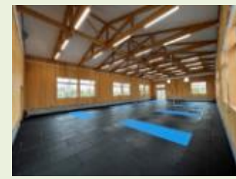
木造化・木質化例
