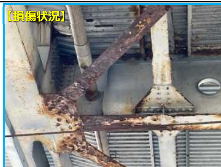
損傷・修繕（塗装塗替）状況【米原跨線橋】
