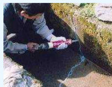
水路のひび割れ補修
