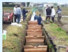
水路魚道の設置（堰上式）
