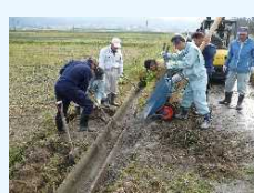
水路法面の初期補修
