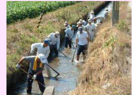
水路の泥上げ
