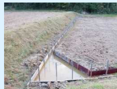
水田内水路の設置
