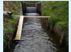
水路からの脱出施設の設置
