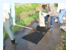
農道の部分補修
