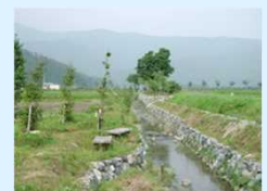
石積水路の設置
