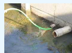
暗渠施設の清掃
