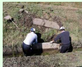
排水路の補修
