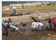
浄化池の泥上げ
