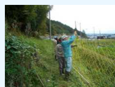
鳥獣害防護柵の補修・設置
