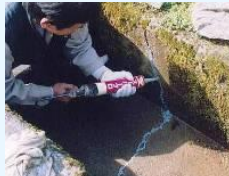
水路のひび割れ補修
