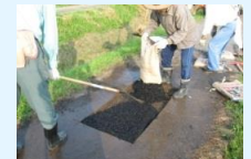
農道の部分補修
