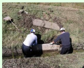
排水路の補修
