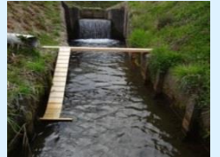
水路からの脱出施設の設置
