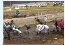
浄化池の泥上げ
