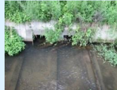
魚巢ブロックの設置
