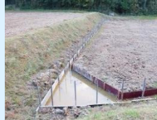
水田内水路の設置
