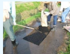
農道の部分補修
