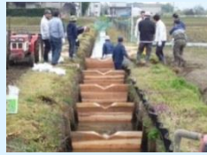
水路魚道の設置(堰上式)
