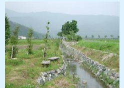
石積水路の設置
