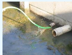
暗渠施設の清掃
