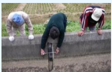
施設の機能診断
