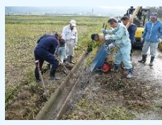
水路法面の初期補修
