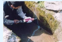
ひび割れの補修
