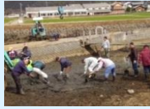
浄化池の泥上げ
