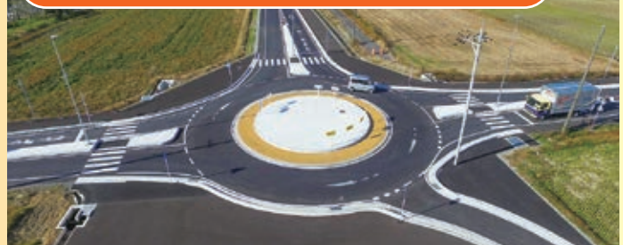
日野徳原線 内池バイパス R2年11月供用
