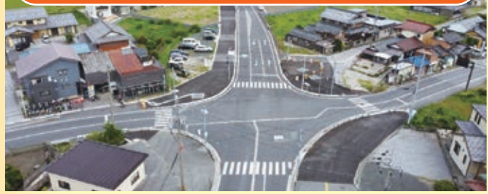
大野木志賀谷長浜線 長岡バイパス R5年7月供用
