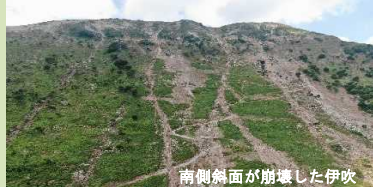
南側斜面が崩壊した伊吹
