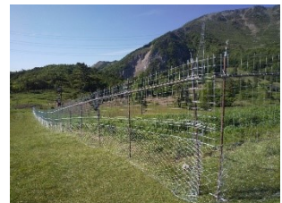
金属柵設置完了
