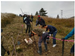
支柱の打ち込み準備
