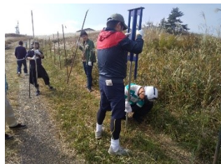
支柱の打ち込み
