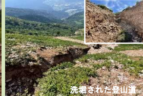
洗掘された登山道
