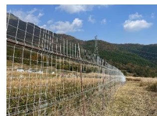
金属柵設置完了
