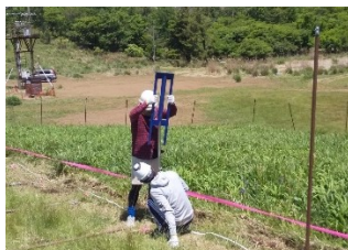
支柱の打ち込み
