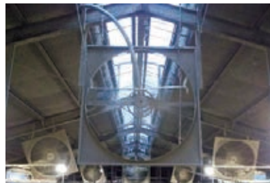
換気扇の設置
