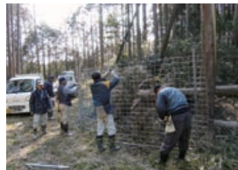
獣害防止柵の補修
