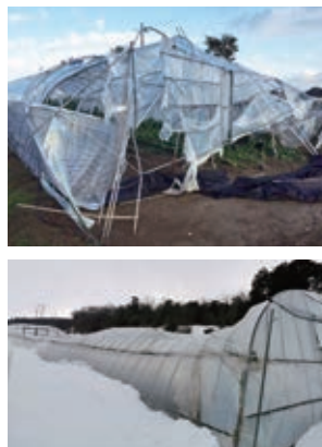
災害によるハウスの倒壊 (上：台風 下：大雪)
