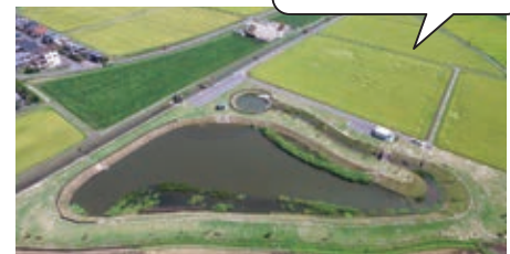
農業排水を浄化・循環利用するために造成した池
