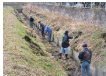
水路の泥上げ
