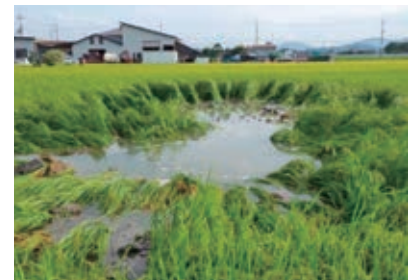
管水路の破損
