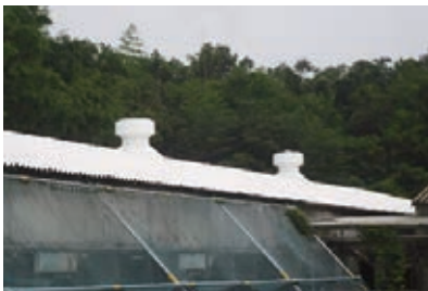
屋根への消石灰の塗布
