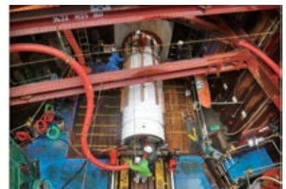
管水路の保全更新
