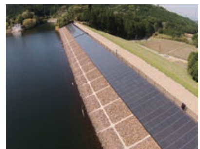
ため池法面での太陽光発電
