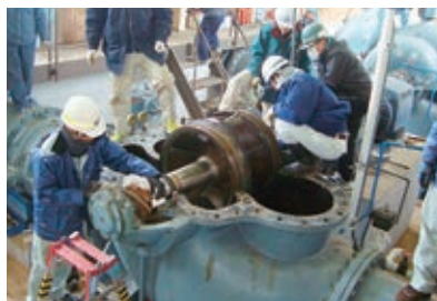
ポンプの機能診断
