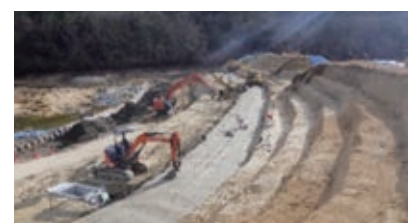
改修中のため池
