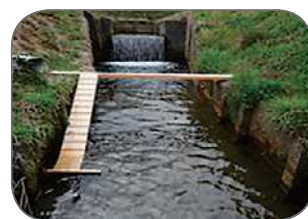
水路からの脱出施設
