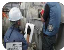
ポンプの点検
