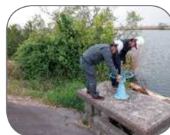
仕切弁の点検
