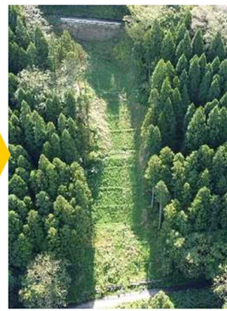
山腹工施工後約2年後の様子
