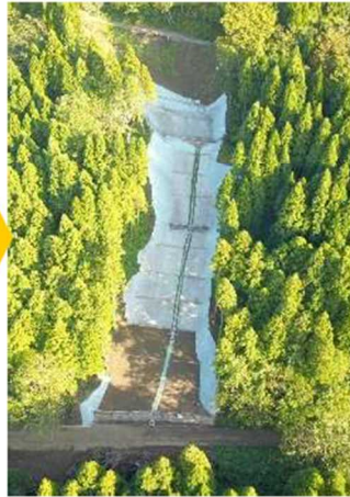
山腹工施工直後の様子
