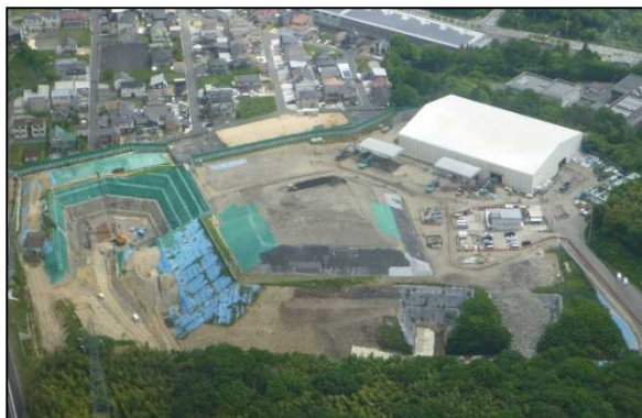
工事中（平成28年5月）の旧処分場
