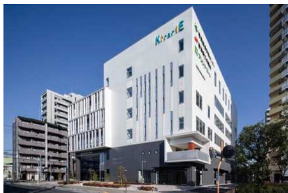
高次都市施設（地域交流センター〔購入費〕） 草津駅周辺都市機能誘導区域地区
