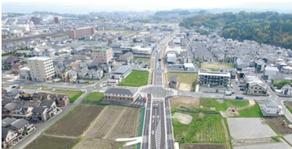
堅田駅西口土地区画整理事業 大津市
