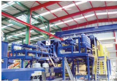
工場見学を行っている
