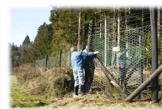
獣害防止柵の補修
